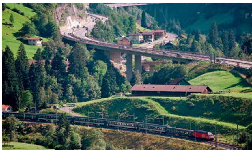
Trojice serpentin u švýcarské vesničky Wassen zaručuje, aby stoupání nepřekročilo 27 promile
