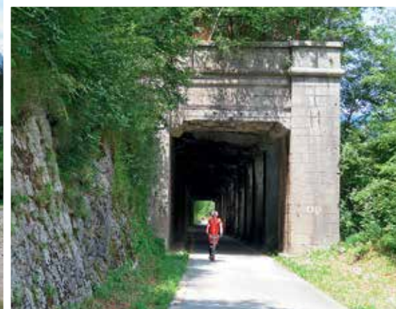
Cyklostezka po zrušené železnici Pontebanna
