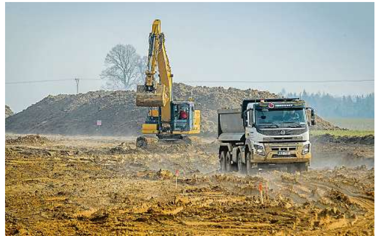
Kvůli rozhodnutí soudu se musela stavba obchvatu u Chýnova na Táborsku zastavit. Místní jsou naštvaní. FOTO | PETR LUNDÁK, MAFRA
