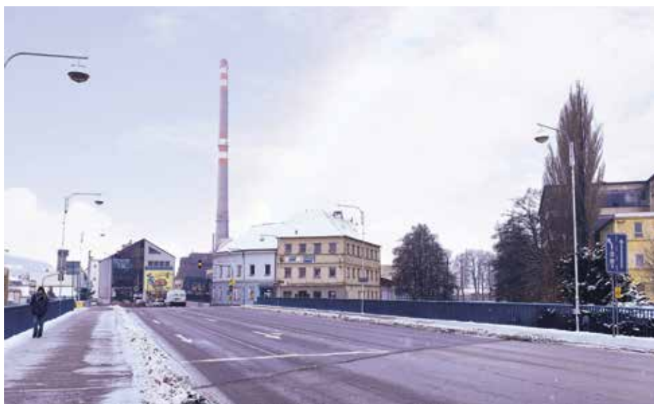
Opravou projde i druhá část Palachova mostu
