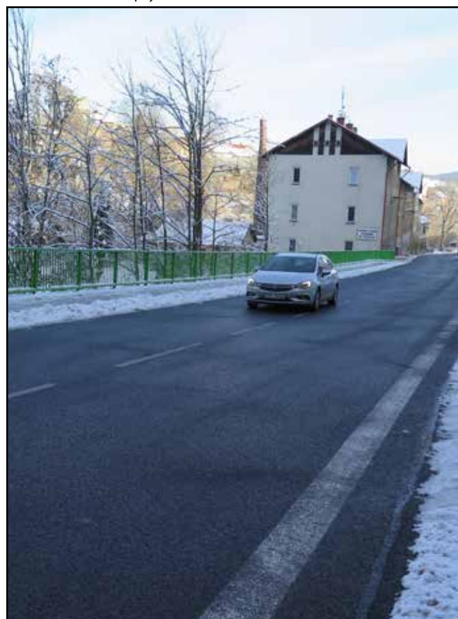
Oprava komunikace I/4 v majetku ŘSD byla v prosinci dokončena.
