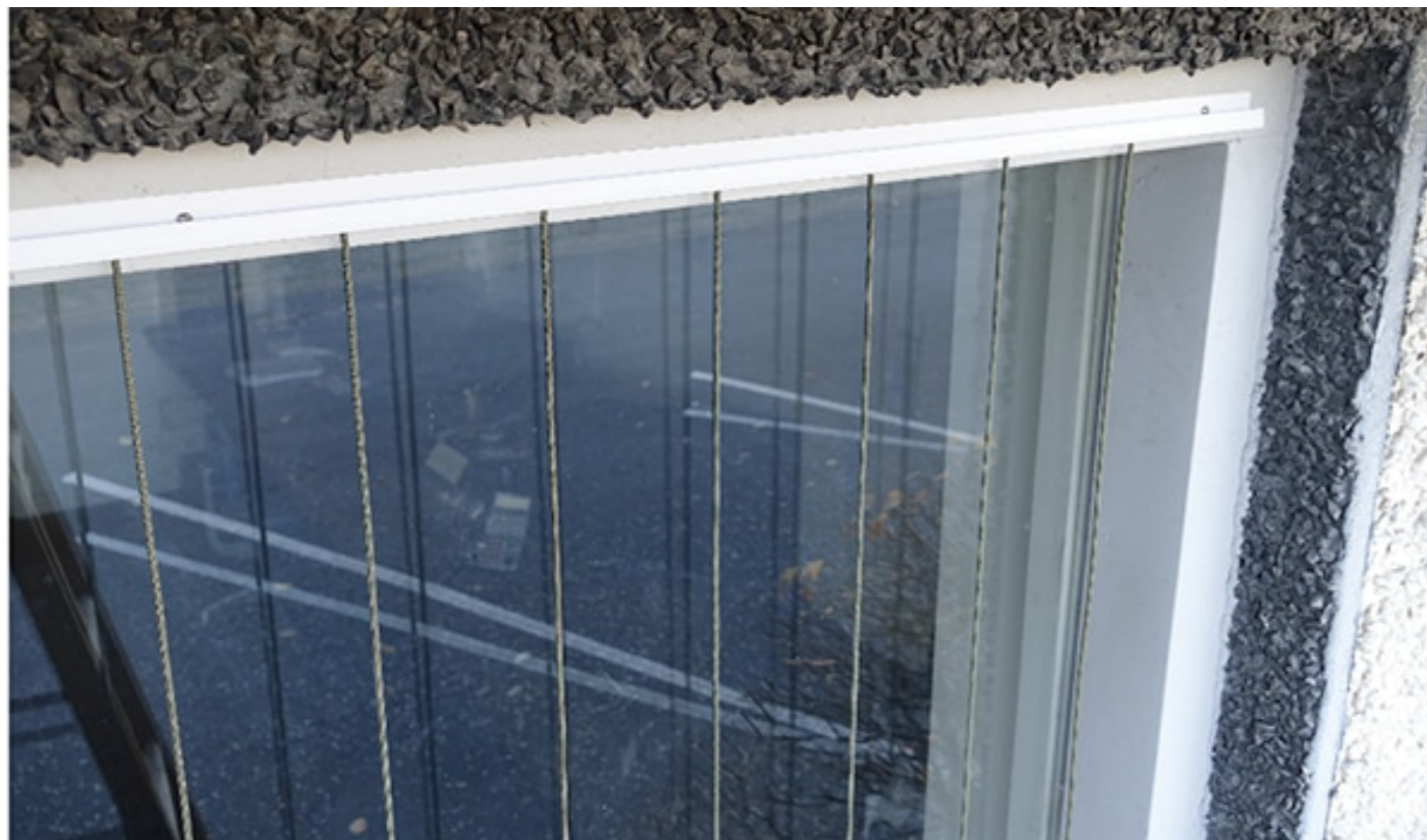
Obr. 4: Instalované Acopian BirdSavers s využitím plastového U-profilu. Vedle přivrtání lze lištu i přilepit pomocí oboustranné lepenky. Fotografie použita se svolením Jeffu Acopiana, www.birdsavers.com .
