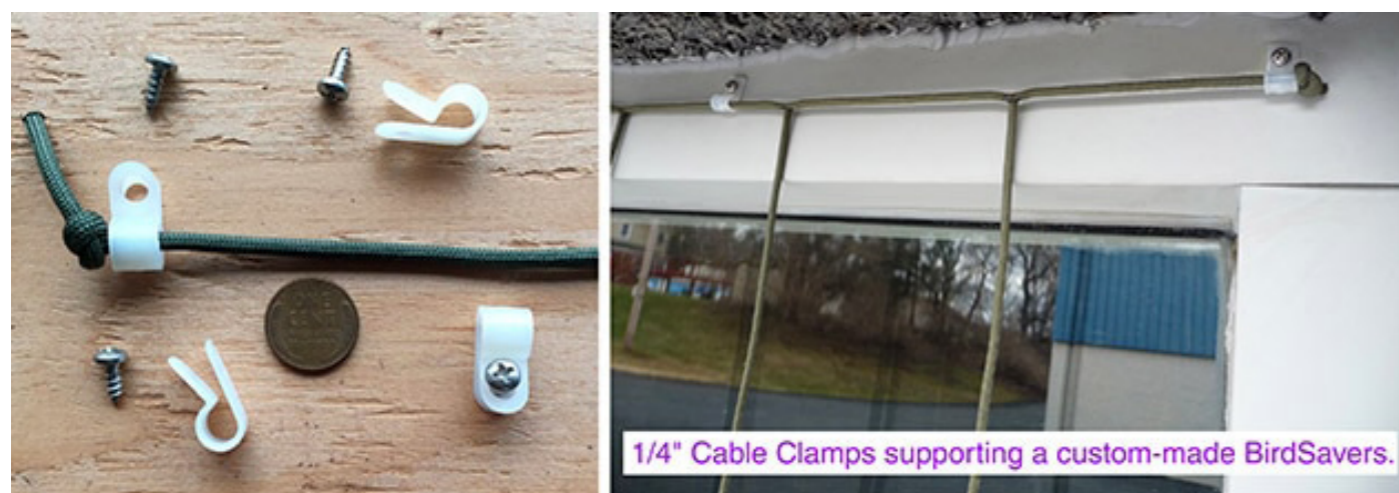
Obr. 2: Příklad uchycení horizontální šňůry na okno pomocí přichytky na kabely. Použit lze i nalepovací háčky mezi které se šňůra uváže. Fotografie použita se svolením Jeffa Acopiana, www.birdsavers.com .
