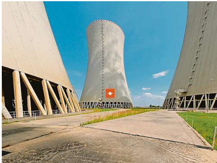
Na netradiční prohlídku areálu zve na webových stránkách i Jaderná elektrárna Temelín.
