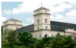
Zámek Račice, přestavba
