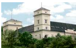
Zámek Račice, přestavba
