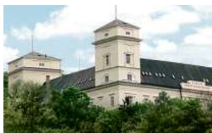
Zámek Račice, přestavba
