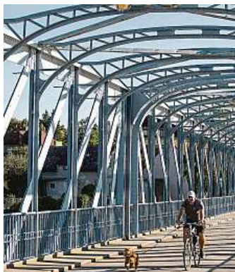
Most v Týně nad Vltavou je příliš nízko nad hladinou. FOTO | MAFRA
