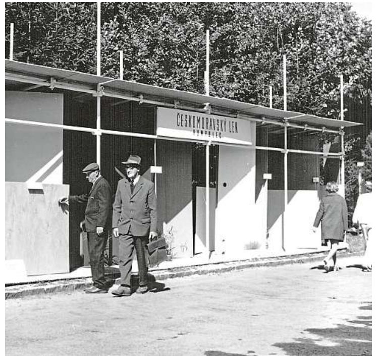
V prvních letech provozu výstaviště si museli vystavovatelé vystačit se stánky sestavenými z lešenářských trubek.
