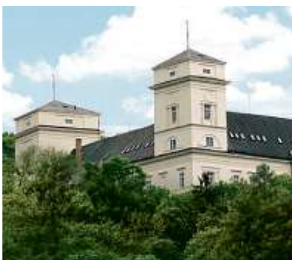
Zámek Račice, přestavba
