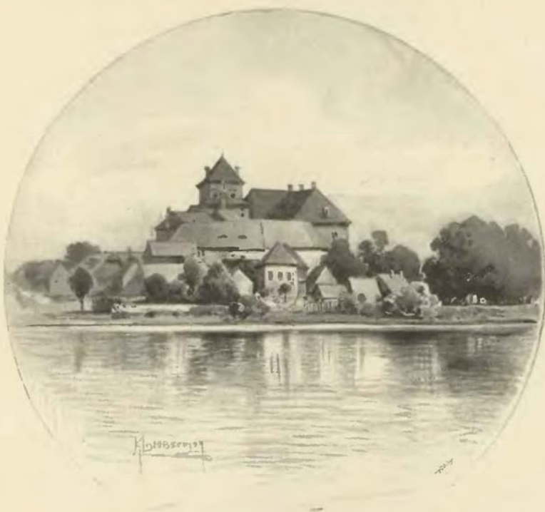
Pohled na Rožmitál od severní strany.
