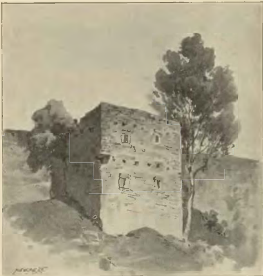
Zbytky hradeb a bašt v Horažďovicích.
