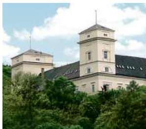
Zámek Račice, přestavba
