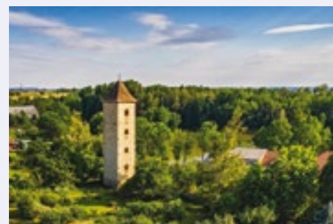
Stará vodárenská věž
