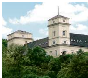
Zámek Račice, přestavba
