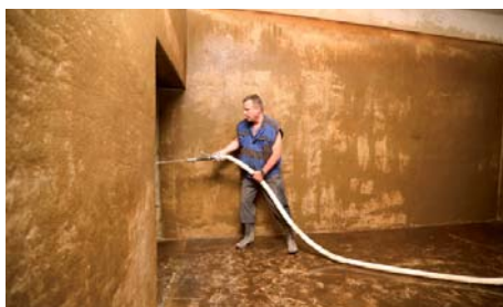
NÁDRŽE Během odstávky došlo i na čištění vodních nádrží, které jsou v podzemí.
