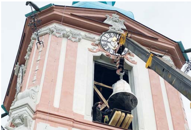
Mariánské poutní místo v Horní Polici má nové zvony. O víkendu je za dozoru zvonáře Petra Rudolfa Manouška a tamního administrátora P. Stanislava Příbyla zavěsili technici. Snímek archiv farnosti
