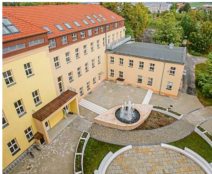
Po třech a půl letech se zde podařilo písecké akademii dokončit rozsáhlou rekonstrukci za 90 milionů korun.
