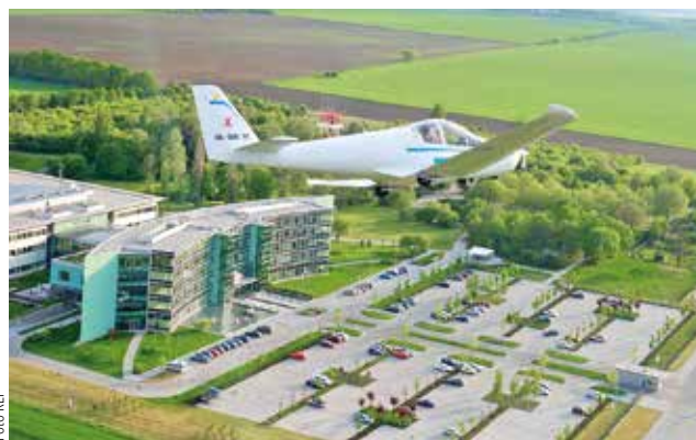
CENTRÁLA. Státní podnik Řízení letového provozu sídlí v rozsáhlém areálu v Jenčíně u Prahy.
