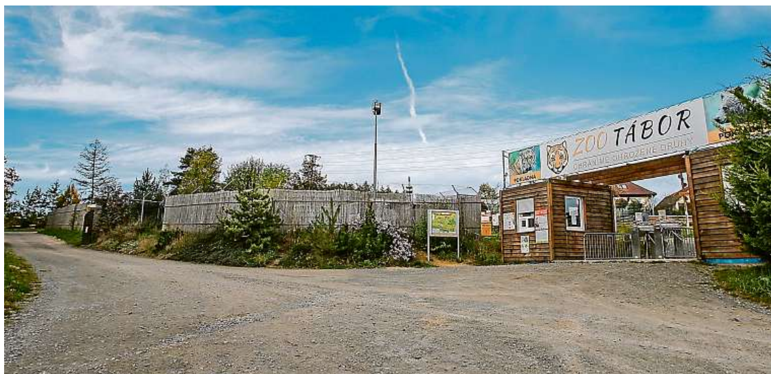
Zoo Větrovy nemá žádnou příjezdovou cestu. Místním obyvatelům vadí prach i hluk.
