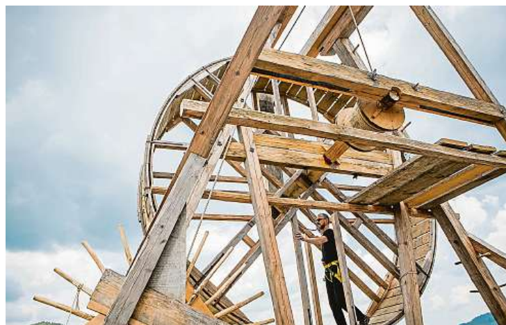
Replika středověkého jeřábu na vrcholu věže Jakobínka v Rožmberku nad Vltavou byla poháněna jen lidskou silou.
