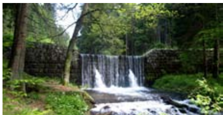
Foto: Hynek Hladík (přehrážka na Zlatém potoce v říčním km 1 944)
