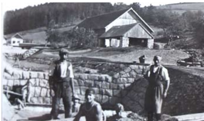
Foto: Ing. Šára (stavba stupně na Zlatém potoce pod Winterovým mlýnem)
