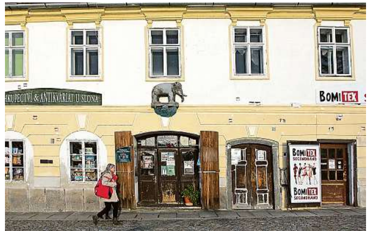
Dům U Slona je jedním z neznámějších píseckých staveb. Jeho fasádu zdobí kamenný reliéf. FOTO | MAREK PODHORA, MAFRA
