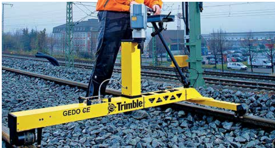
Měření správného rozchodu mezi kolejnicemi
