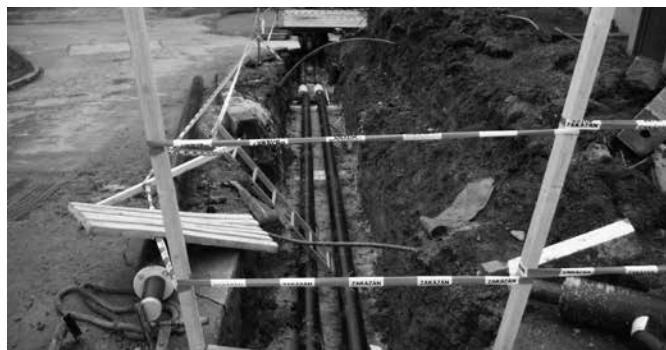
Budování teplovodů na starém sídlišti.
