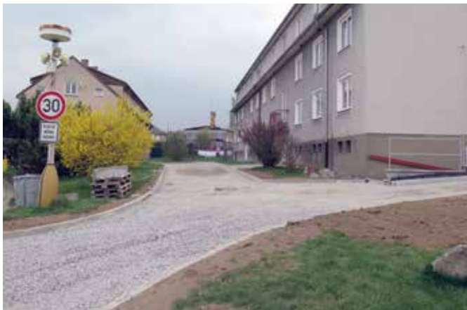
Rekonstrukce cest v Boubínské ulici.
