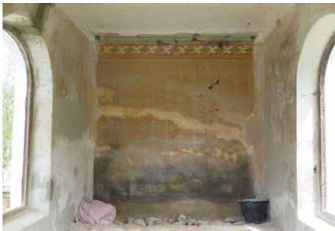
Současný interiér opravované kapličky v ulici K. Světlé.
