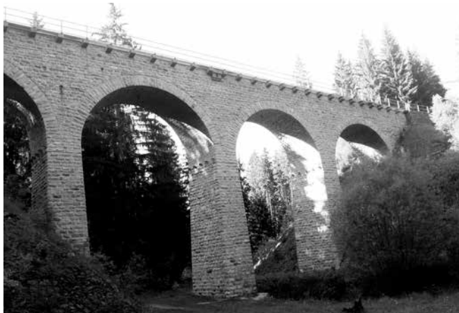
Klášterecký viadukt je významnou technickou památkou.
