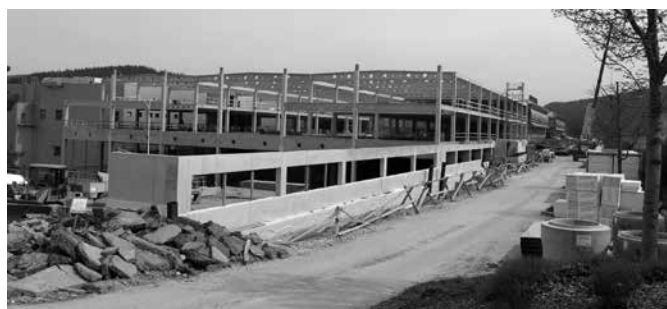
Výstavba nové haly Rohde-Schwarz probíhá velmi rychlým tempem.
