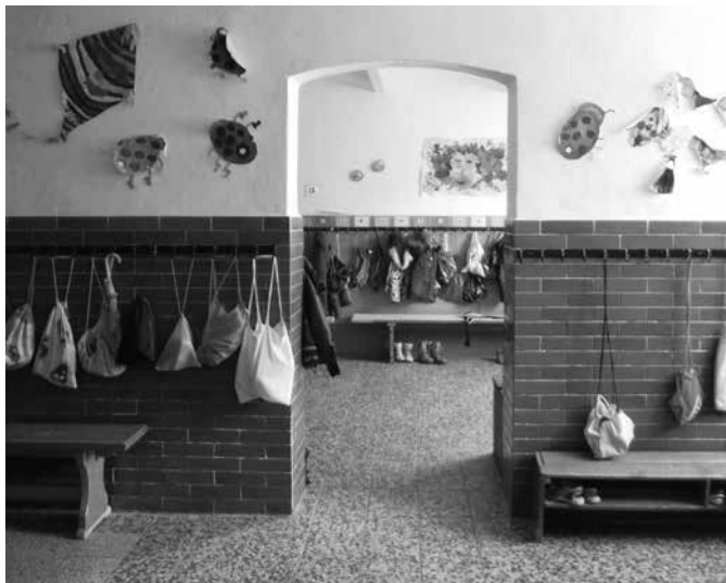
Šatny v suterénu školy budou stavebně upraveny.
