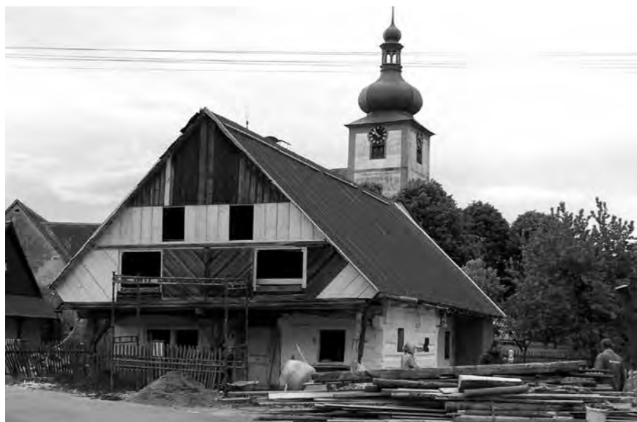
LOMENICE A DŘEVĚNÉ VÝPLNĚ OKENNÍCH A DVEŘNÍCH OTVORŮ BYLY REPASOVÁNY.
