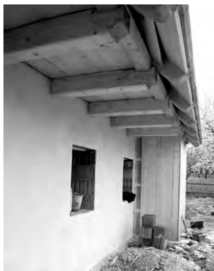
NA MÍSTĚ ZŘÍCENÉ ČÁSTI VZNIKLA NOVOSTAVBA.
