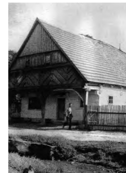
PŘEDSUNUTÝ ŠTÍT S LOUBÍM NA HISTORICKÉM SNÍMKU
