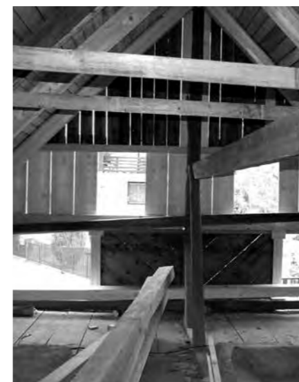
NÁSLEDOVALA TESAŘSKÁ OBNOVA ROUBENÉ KONSTRUKCE, KROVU A POKLÁDKA STŘEŠNÍ KRYTINY.
